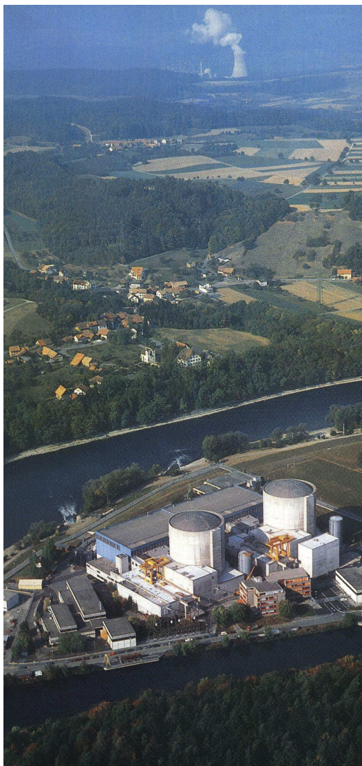
Rys. 5. Elektrownia jądrowa Beznau z dwoma blokami po 350 MW e zlokalizowana na wyspie. Widoczna w górnej części zdjęcia druga elektrownia jądrowa Leibstadt odległa od Beznau zaledwie o 18 km
